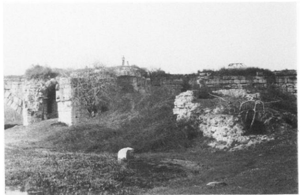
(d) Breakwater from south.
